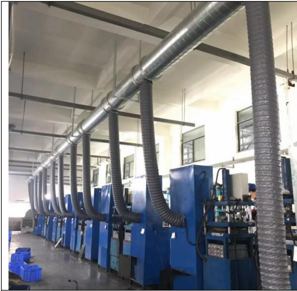
集气罩+油烟净化+UV 光氧催化+活性炭吸附+15 米排气筒（硫化车间 2）
