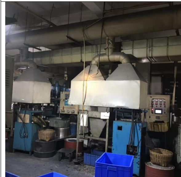
集气罩+油烟净化+UV 光氧催化+活性炭吸附+15 米排气筒（硫化车间 1）
