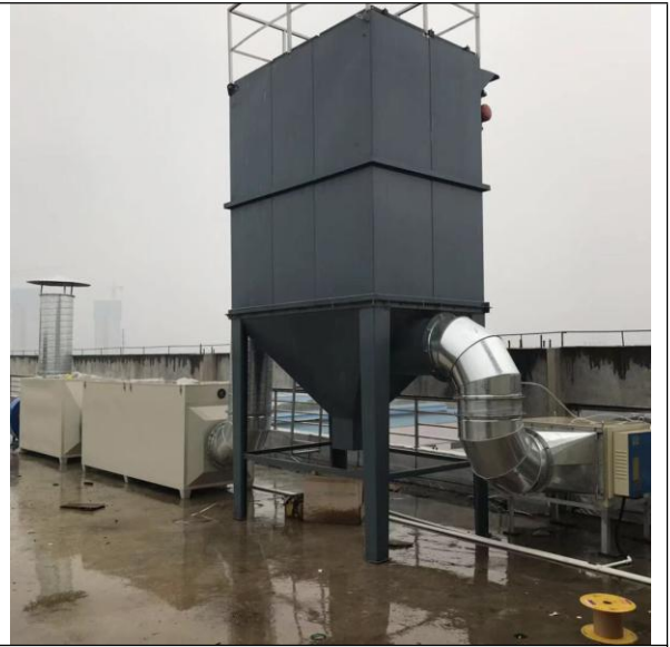
集气罩+油烟净化+UV 光氧催化+活性炭吸附+15 米排气筒（硫化车间 2）
