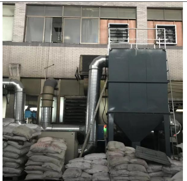
集气罩+油烟净化+UV 光氧催化+活性炭吸附+15 米排气筒（硫化车间 1）
