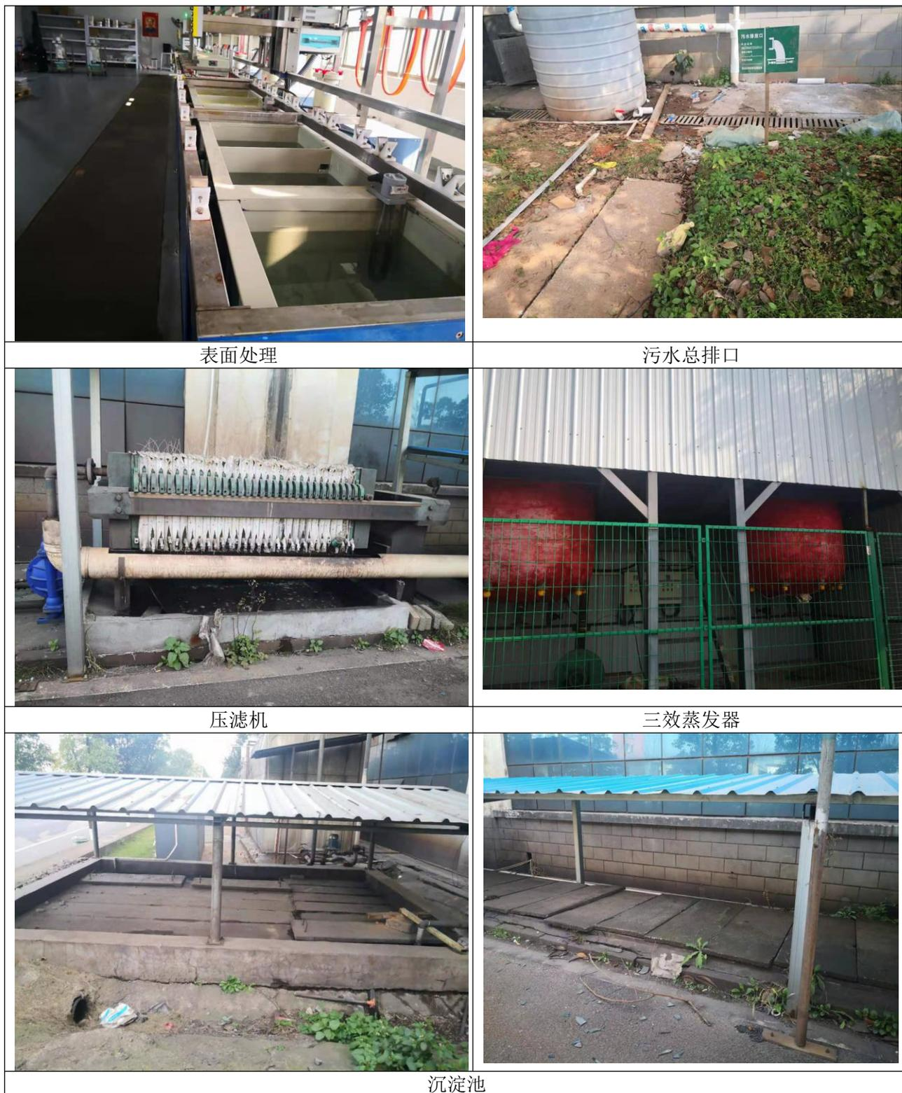
图 4.1-1 项目废水处理设施照片
