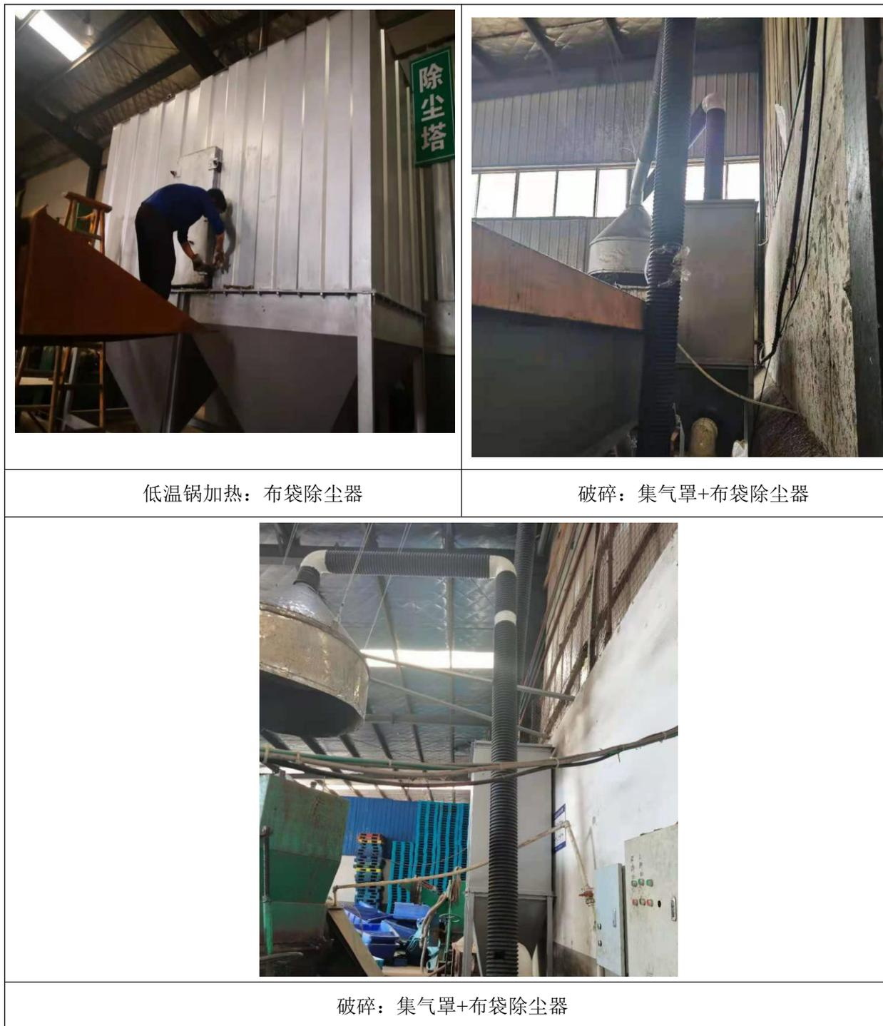
图 4.1-2 项目废气处理设施照片
