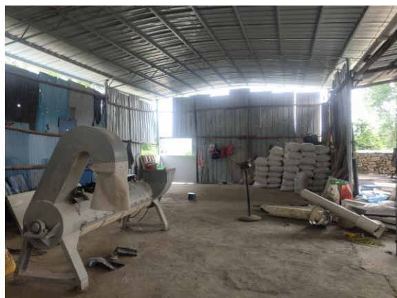
生产车间现状
