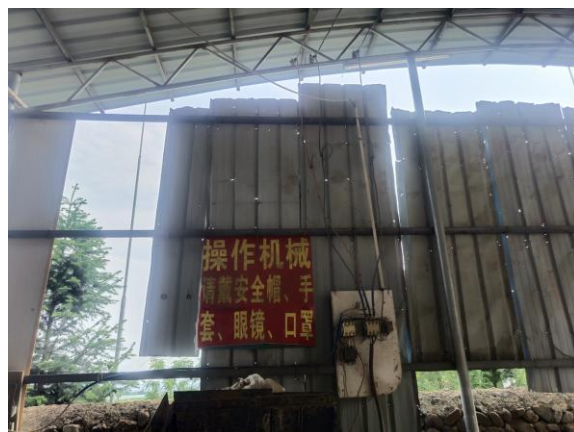
生产车间现状
