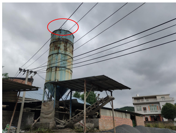
筒仓自带除尘器
