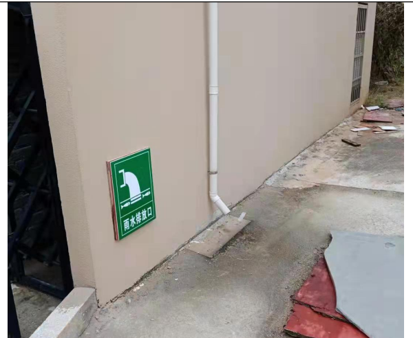
整改后雨水排放口
