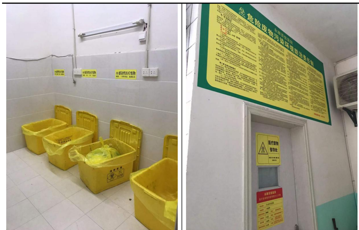
医疗废物暂存间
