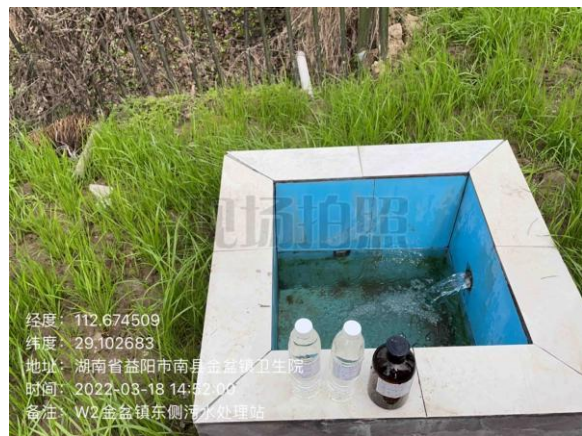
金盆镇东侧污水处理站出口采样照片
