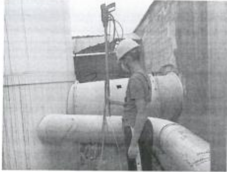
A 1 ①12 栋喷锡废气进口 1 废气采样
