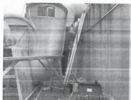
A 6 ⑥12 栋酸性废气进口 2 废气采样
