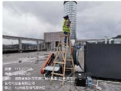
A 4 有组织废气采样照片
