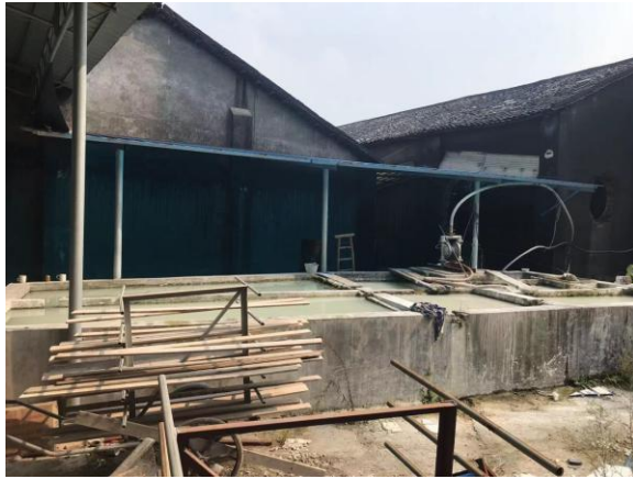
洗坯废水沉淀池
