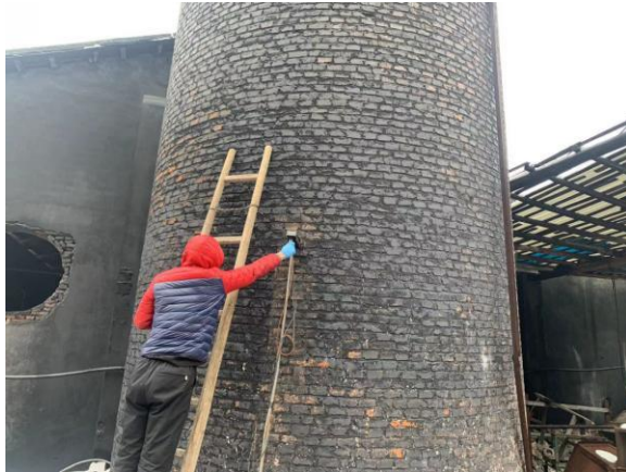
烧成废气排气筒出口
