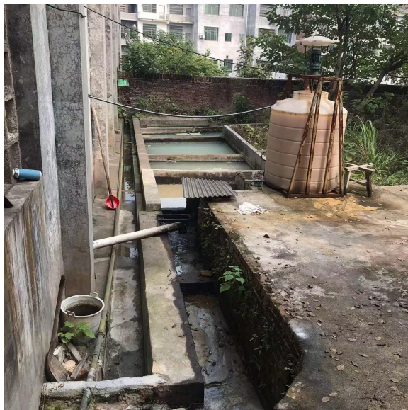
设备清洗废水沉淀池
